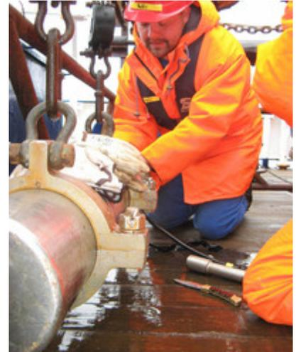
Seismiker bei der Montage eines Luftpulsers. (Foto: N. Kaul)
