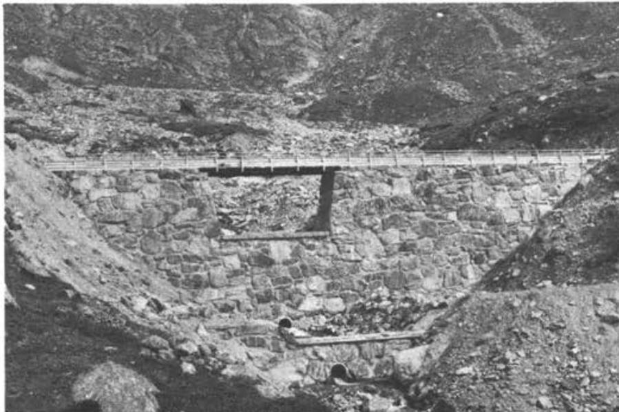
Abb. 7. Sperre im Fällbach mit Brücke als Zufahrt zur Grubenalp.
