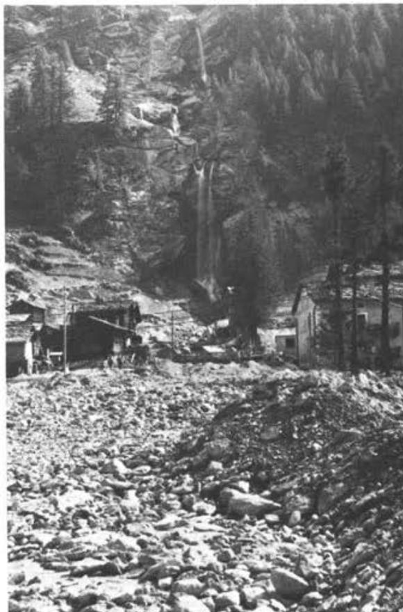
Abb. 4. Wasserfall und der durch das Hochwasser vom 2. Juli 1968 zerstörte Kanal des Fällbaches in Saas Balen.
