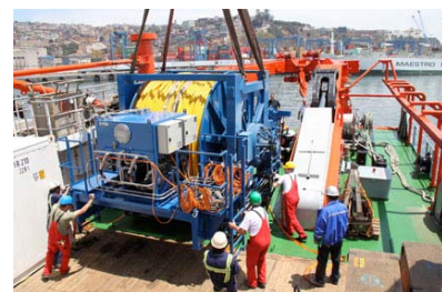
Installation der Seismik-Winde auf dem Achterdeck (Foto: Thomas Ronge)
