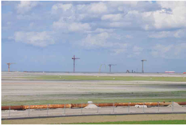
Abbildung 11: Baumaßnahmen wie hier die Errichtung eines Containerterminals am Jade-Weser-Port bei Wilhelmshaven zerstören wichtige Küstenlebensräume und koppeln Land- und Meeresökosysteme voneinander ab. Der verstärkte Schiffsverkehr hat negative Auswirkungen auf z. B. Schweinswale (Foto: Kolja Beisiegel). → 14, 15
