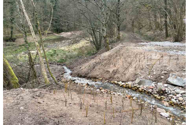
Abbildung 17: Renaturierungsarbeiten an einem zuvor aufgestauten Bachlauf im Grünbachtal nahe Baden-Baden (Foto: Julia S. Ellerbrok). → 27
