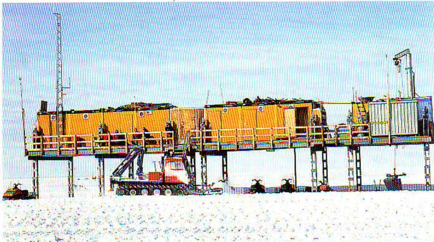
**Abb. 3.** Die deutsche Sommerstation Filchner auf dem Ronne Ice Shelf, Antarktis, erbaut 1984. Um ein Zudriften der Station durch Schnee zu verhindern, müssen die Stelzen, auf denen die Plattform ruht, in zwei- bis dreijährigem Rhythmus um ca. 1 m verlängert werden. Die Station bewegt sich mit dem Schelfeis mit einer Geschwindigkeit von 1450 m/a nach Norden, ihre geographische Position betrug 1995 77° 04' S, 50° 08' W (Foto: Hans Oerter, 24. 2. 92).
