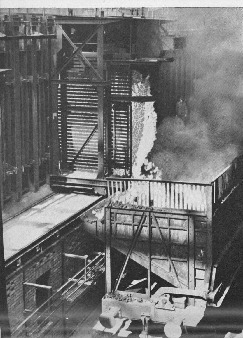
Abb. 8: Kokskuchen während des Ausdrückens durch den Führungswagen in den Löschwagen.
