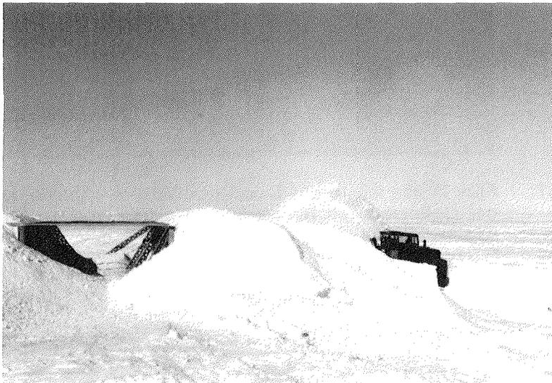
**Abb.46:** Der erste Bauabschnitt: An die Schalungswände wird mit Hilfe der Schneefräse angeblasen. So konnte ein Höhengewinn von ca. 2.5 Metern gegenüber der normalen Schneeoberfläche erreicht werden.
