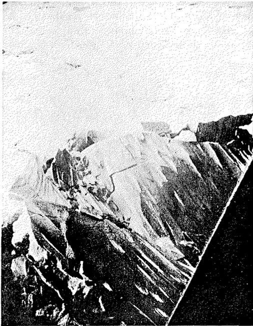
Abb. 8: Arbeit des Eisbrechers im Tellerpackeis, keine weitreichende Sprungbildung, Gävlebucht, Mitte März 1937 (Foto Verf.).
