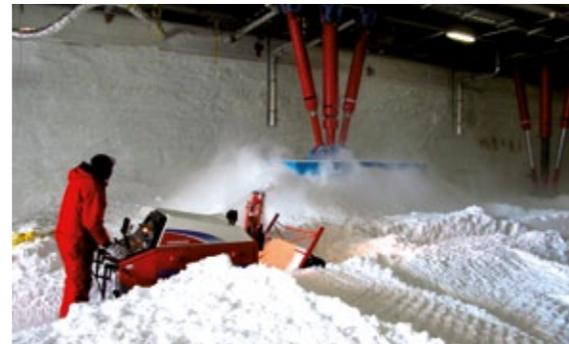
Abb. 4: Schneefräsen blasen Schnee unter die gelifteten Hydraulikstützen. Wenn alle Stützen stabil unterfüttert sind, wird das 2.600 t schwere Gebäude angehoben
