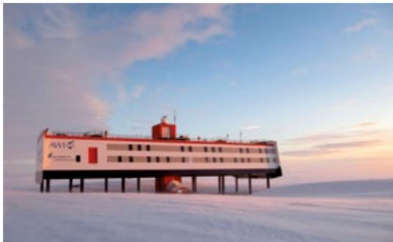
Abb. 3: Hohe Schneewehen nach den Stürmen des Winters. Die ‚Neumayer-Station III‘ kann in jedem Sommer an die neuen Schneehöhen angepasst werden.
