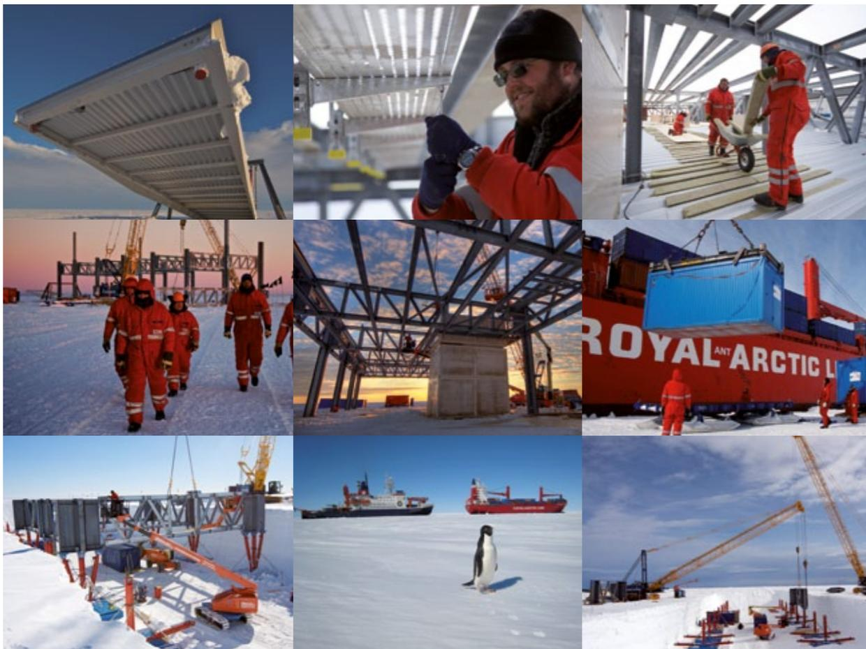
Abb. 1: Sieben Monate dauerten die Bauarbeiten an der ‚Neumayer-Station III‘, verteilt über zwei antarktische Sommer. Etwa 4.000 Tonnen Baumaterial und Ausrüstung wurden in die Antarktis transportiert. In Spitzenzeiten waren bis zu 98 Wissenschaftler, Ingenieure und Techniker auf der Baustelle im Einsatz.
