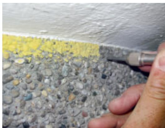
12 Damals übermäßig aufgetragene gelbe Farbspuren wurden auf der grob strukturierten Waschbetonoberfläche mit dem Partikelstrahlgerät schonend wieder reduziert.
