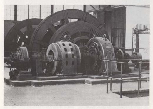
Bild 14: In der Zeche Zollern II steht die erste elektrische Fördermaschine der Welt an ihrem ursprünglichen Standort
