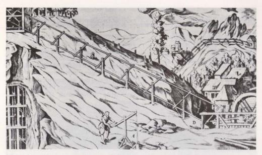
Bild 6: Das Feldgestänge überträgt die Kraft vom Wasserrad auf eine Pumpenkunst
