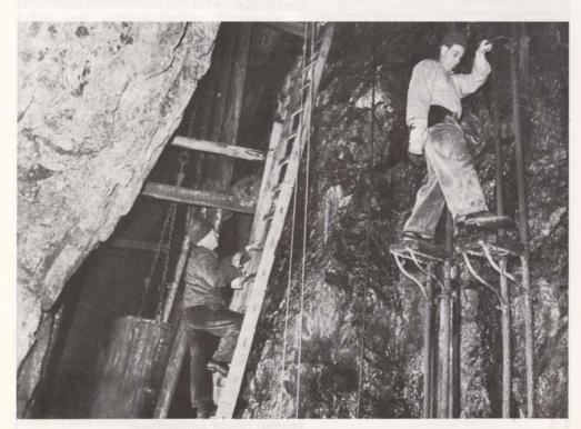
Bild 4: Bei der Fahrkunst wechselt der Bergmann nach jedem Hub das Podest — hier am Drahtseil — und gelangt nach über- oder untertage
