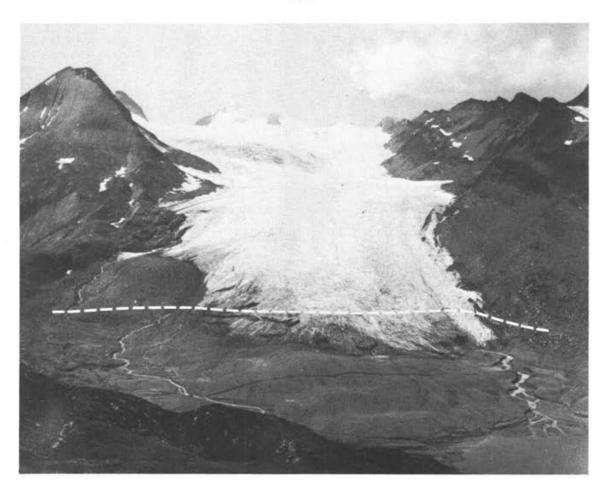
Abb. 2. Ansicht des Griesgletschers. Aufnahme vom 10.8.1964 mit eingetragenem Seespiegel vom 19.9.1966, als 300'000 m<sup>3</sup> Eis überstaut waren und davon 150'000 m<sup>3</sup> gleichzeitig aufbrachen.
