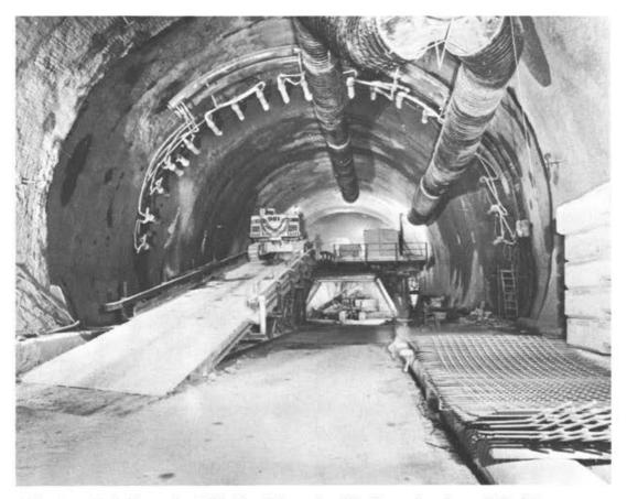
Abb. 17. Aufnahme des Milchbucktunnels, Moränenstrecke mit Gefrierverfahren (Foto: Prader AG)
