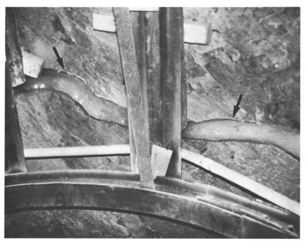
Abb. 6. Eisgefüllte Kluft im Fels des Verbindungsstollens. An dieser Stelle wurden Einbaubogen installiert. (Aufnahme B. Bindschadler, 16.3.79)
