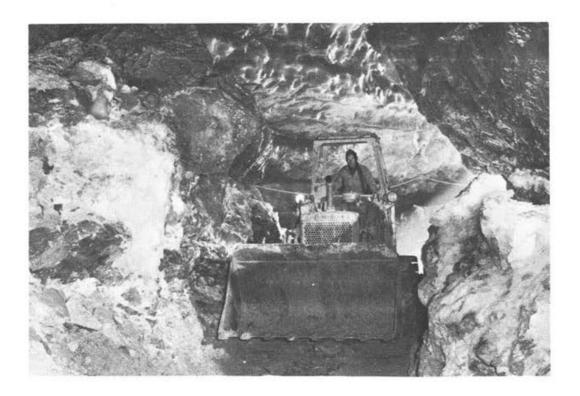
Abb. 5. Bau eines Eisstollens im Grubengletscher im November 1971.
